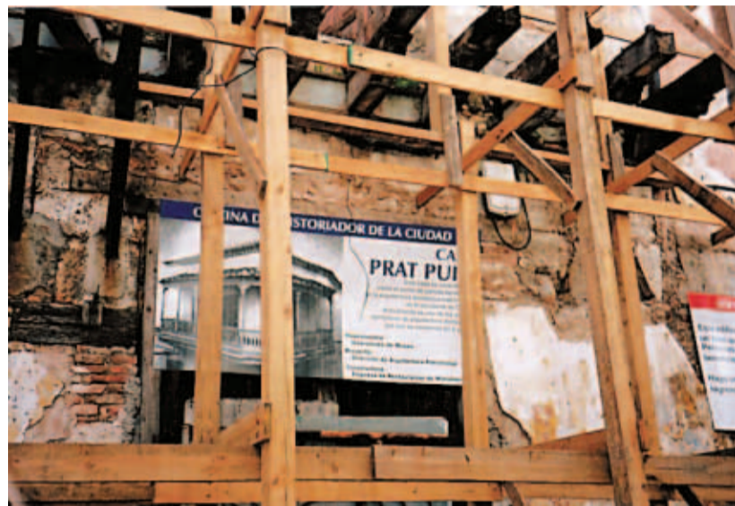
Obras de restauración de la casa Prat Puig, arquitecto catalán exiliado
